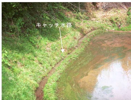
図－６ キャッチ水路
