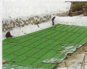
ダム放水口修繕工事
