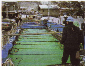
橋梁改良工事
