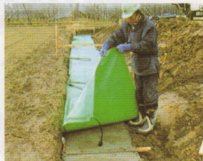
均しコンクリート
